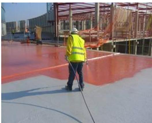
ETANCHEITE CIRCULABLE SOUS PROTECTION LOURDE A PENTE ZERO est un revêtement d'étanchéité circulaire polyuréthane sous protection lourde (gravillons, chape coulée, carrelage collé ou scellé, dalles désolidarisées ou dalles sur plots) pour toitures accessibles ou non, planchers intermédiaires, parois verticales, locaux techniques, pièces humides, cuisines, jardinières.
